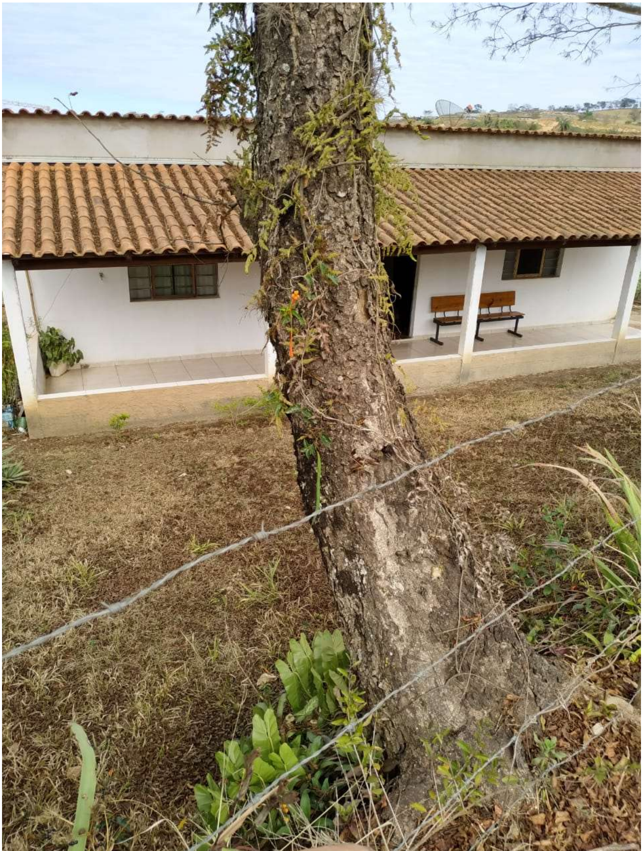
Foto 3 - Vista parcial da aroeira que desenvolveu inclinação acentuada.
