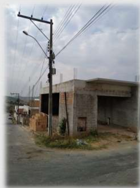
Construção onde se encontrava o antigo "casarão do Nem" - Rua Ferreira Guimarães/Praça Santo Antônio. Autoria: Alexandre de Faria Silva. Registro em 21/09/2020.
